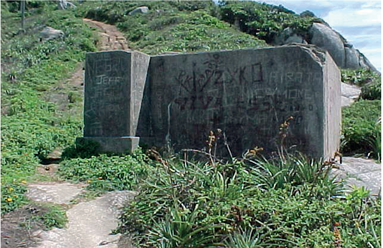
Base da torre metálica treliçada do anterior farol da Ponta Grande (foto ESPF)
