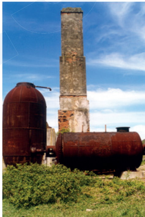
Barracão da Baleia – Armação de Imbituba Remanescentes pós-derrubada das edificações
