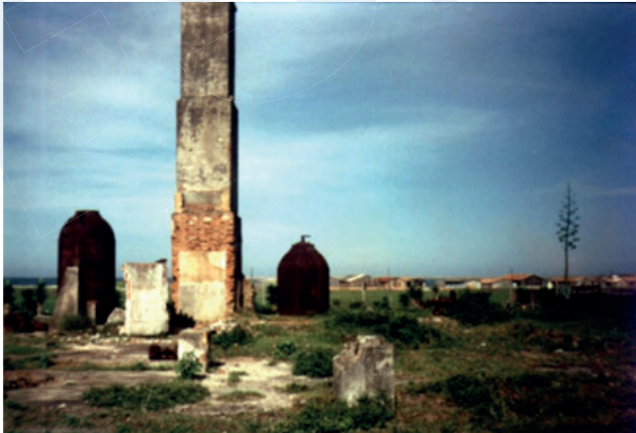
Barracão da Baleia – Armação de Imbituba Remanescentes pós derrubada das edificações
