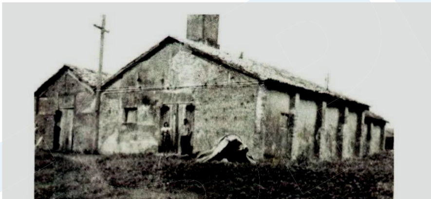
Barracão da Baleia – Armação de Imbituba
