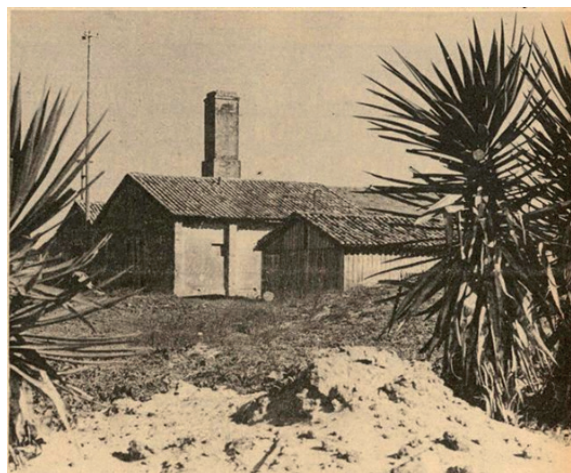
Edificações conhecidas como Barracão da Baleia
